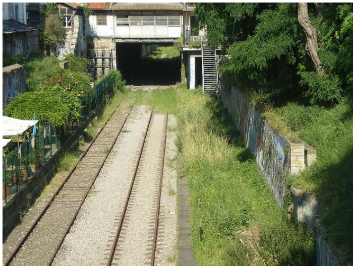
Les quais de la gare désaffectée du boulevard Ornano sur la ligne de Petite Ceinture.
