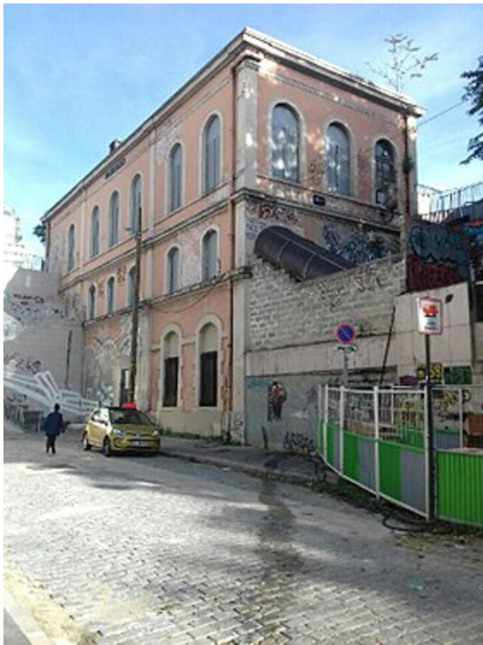
La gare Masséna vue depuis la rue Regnault.
